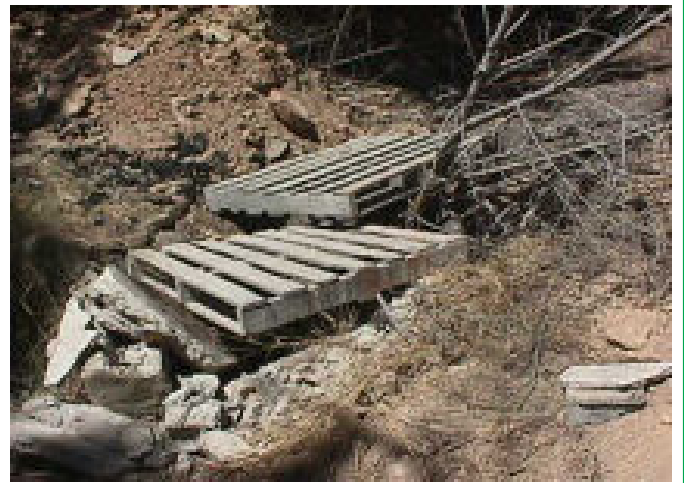
Pozo negro abierto en plena calle
